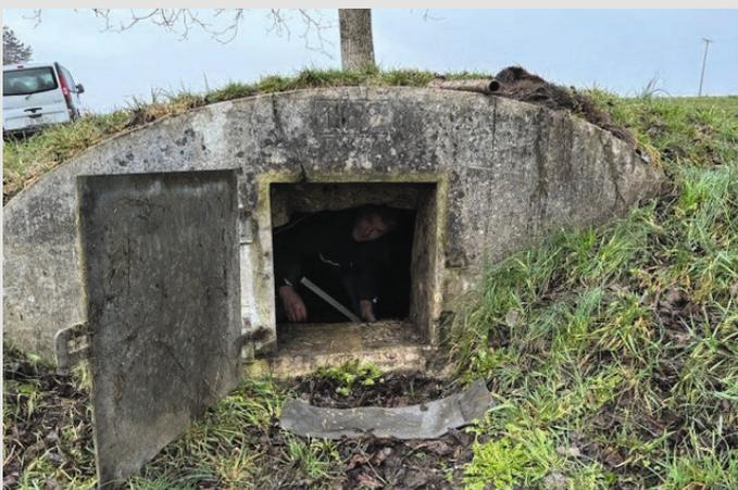
Brunnenstube Rietwis. Zuleitung mit Hochdruck spülen und Brunnenstube reinigen.
