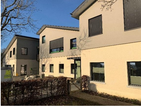
Abb. 26: Gemeindezentrum mit Bistro und Kindergarten
