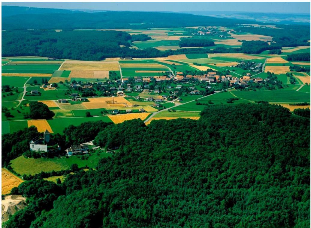
Abb. 22: Luftaufnahme von 1980; im Vordergrund Schloss Herblingen. Quelle: ETH Bibliothek, Bildarchiv online, Bildcode: Com_FC13-8234-015
