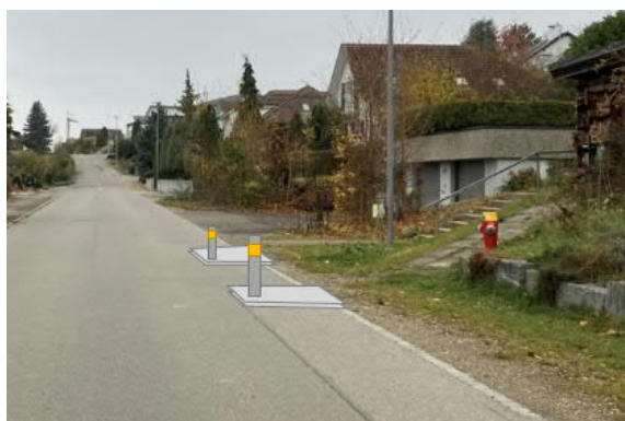
Abbildung 17: Braatistrasse 23, Blick in Richtung Südwesten
