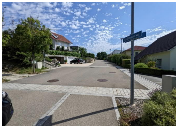
Abbildung 8: Platzgestaltung auf Quartierstrasse (Schalmenackerweg)
